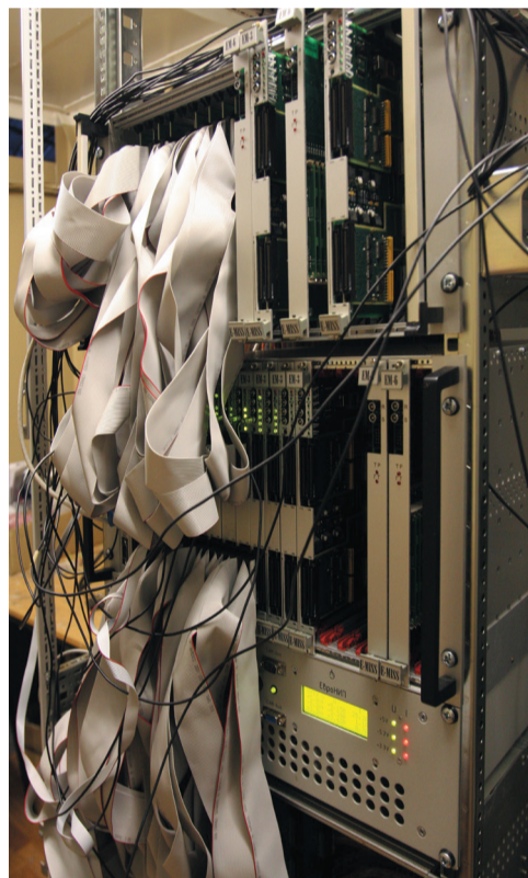
Электронная аппаратура установки СПАСЧАРМ
