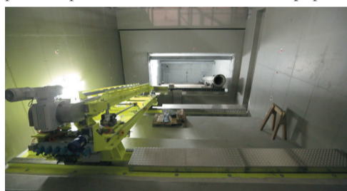
Начало монтажа опор-подставок, устройства установки и удаления поглотителя (Каверна главного поглотителя, Гамбург, Германия)
